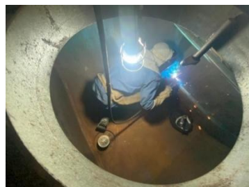
Figura 4: Solda MIG em Espaço Confinado
