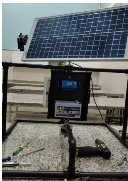
Figura 17 - Montagem da Placa Solar e Estrutura. Fonte: Autor (2022).
