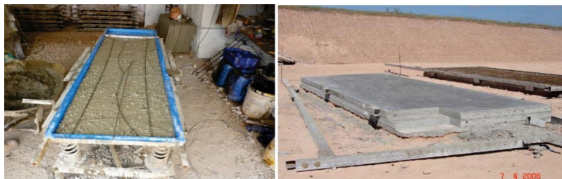
Figura 3 - Construção modular no canteiro de obras
