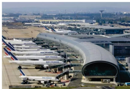
Figura 12 – Ampliação dos terminais do aeroporto Charles De Gaulle, construído através do sistema off-site
