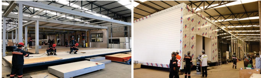
Figura 2 - Construção modular produzida totalmente em ambiente industrial para posterior transporte e alocação
