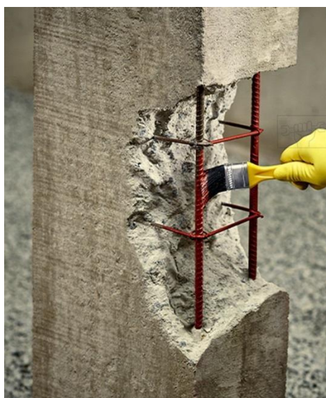
Figura 7 - Aplicação de revestimento Armatec ZN e Primer em estrutura metálica
