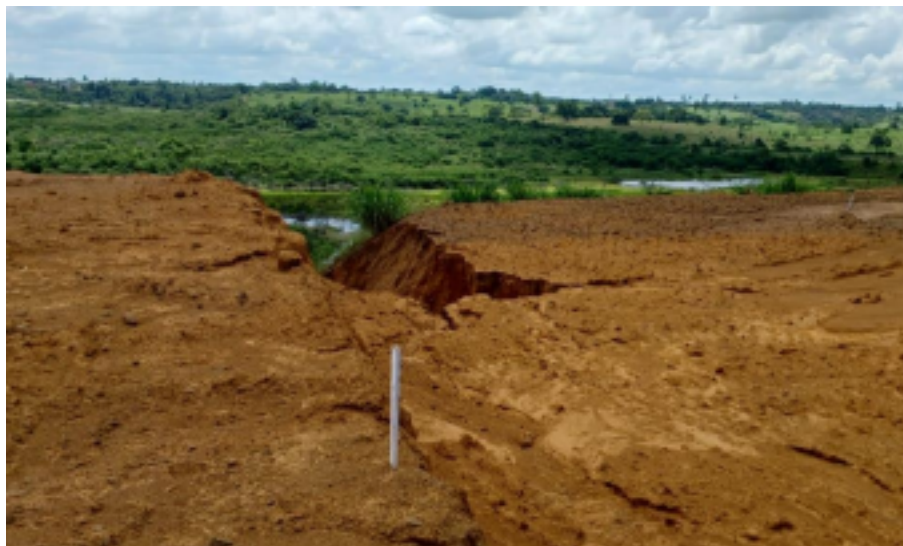
Figura 3. Erosão em talude causada pela chuva que poderia ser evitada pela Biomanta.
